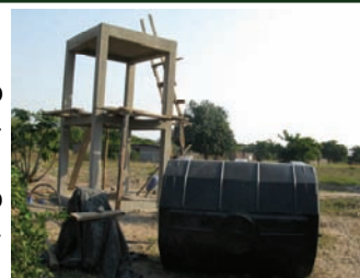
Obras finais do Furo do Francisco, em Chaquelane
